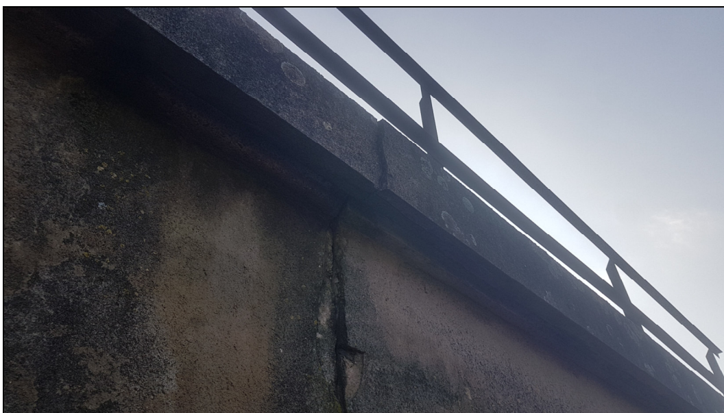
Obr. č. 9 – vyklonění konstrukce na styku opěry a křídla
